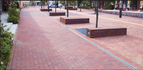
モルタル施工
